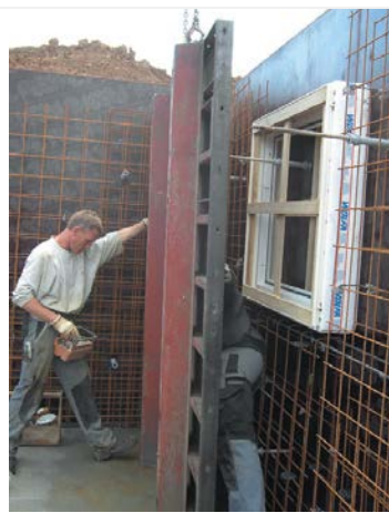
Innere Schalung stellen – betonieren
