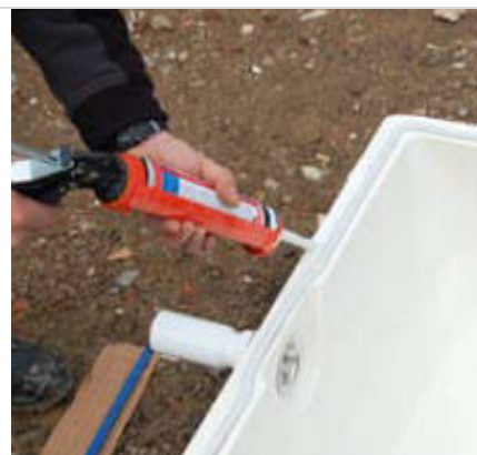
... einen Teil des Kartuschenmaterials großzügig auf den Lichtschacht-Flansch auftragen
