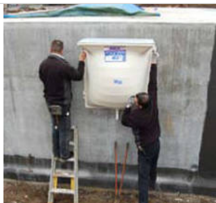
Rost einhängen und Grundbohrlöcher anreißen, bohren und Fixanker einschlagen
