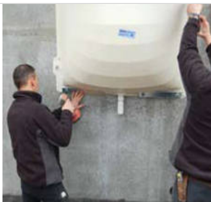
Lichtschacht mit dem restlichen Kartuschenmaterial innenseitig abspritzen. Die Abdichtung einen Tag aushärten lassen und
