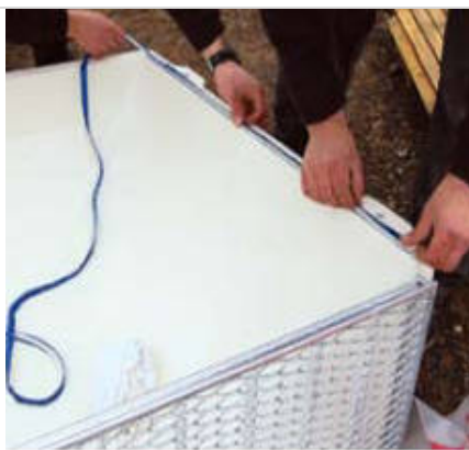
Abdichtungsband in die Aufnahmenut des Lichtschachtes einkleben und
