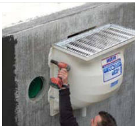
Das zusätzliche Schienenset anbringen und alle Schrauben handfest anziehen
