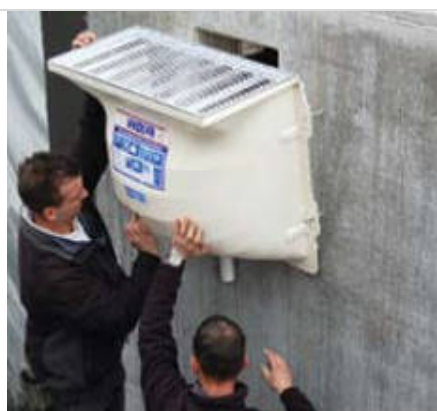
Lichtschacht mit Rost an den Fixankern einhängen und
