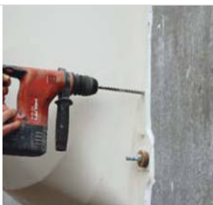
leicht anschrauben. Zusätzliche Befestigungslöcher bohren.
