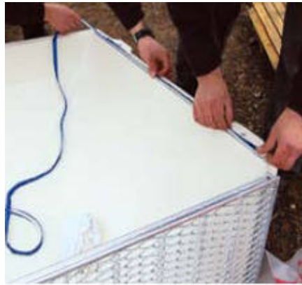
Τοποθέτηση σφραγιστικού υλικού
