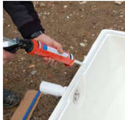
Εφαρμογή σφραγιστικού υλικού
