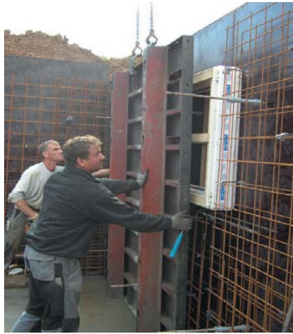
Τοποθέτηση / κλείσιμο ξυλότυπου έτοιμο προς σκυροδέτηση
