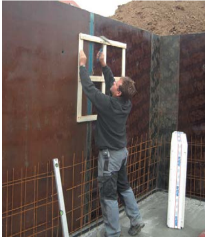
Τοποθέτηση ξύλινου τελάρου/οδηγού στο ξυλότυπο
