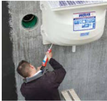
Εφαρμογή σφραγιστικού υλικού
