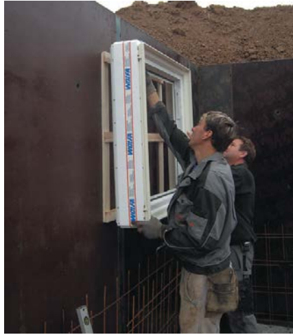
Τοποθέτηση και στερέωση παραθύρου στο ξυλότυπο
