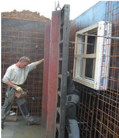
Τοποθέτηση / κλείσιμο ξυλότυπου έτοιμο προς σκυροδέτηση
