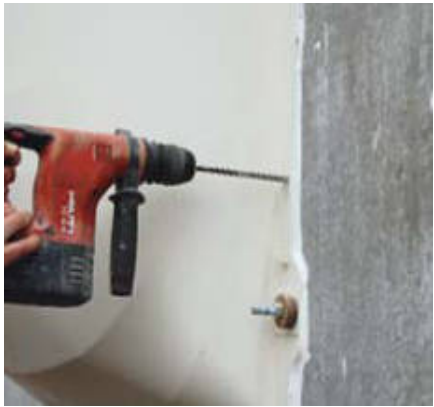
Πρόσθετη μηχανική στερέωση
